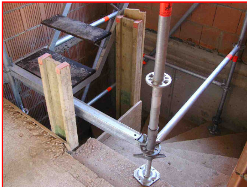
Aufbau auf vorhandener Kellertreppe.
