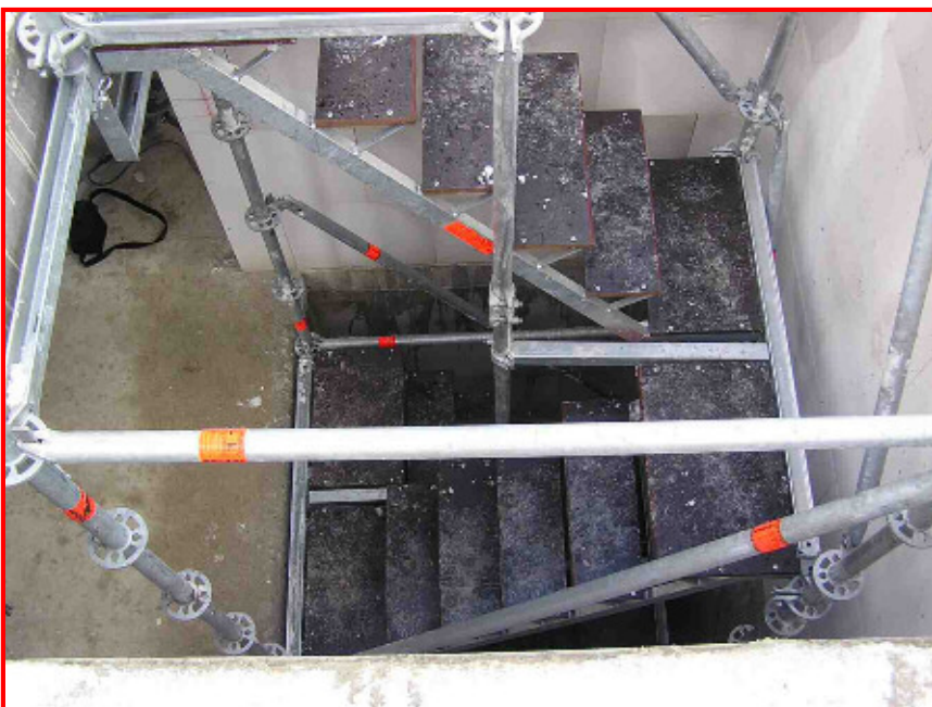
Gegenläufiger Aufbau auf Adapterplatten zur unbehinderten Estricheinbringung
