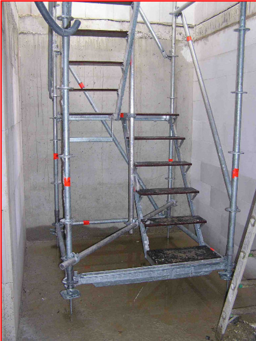
Gegenläufiger Aufbau auf Adapterplatten zur unbehinderten Estricheinbringung
